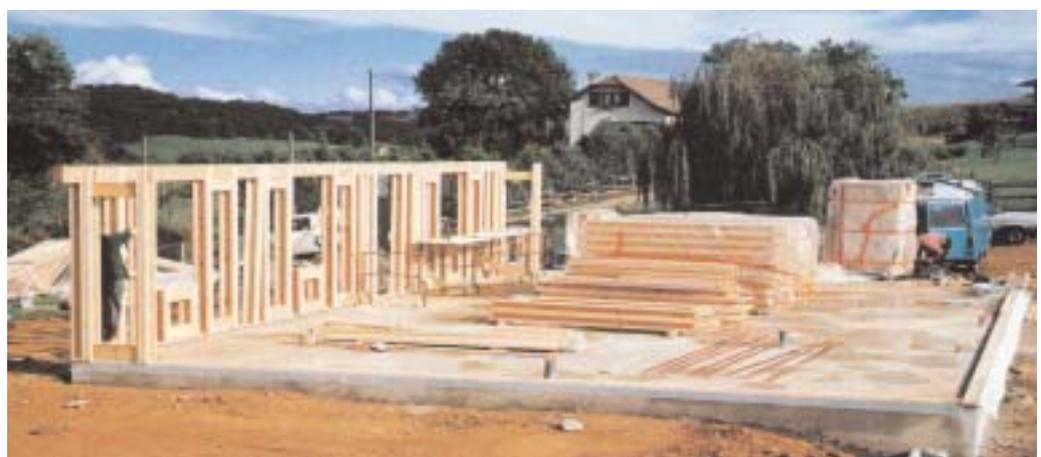
Immagine del cantiere in una fase iniziale di assemblaggio delle singole pareti esterne
