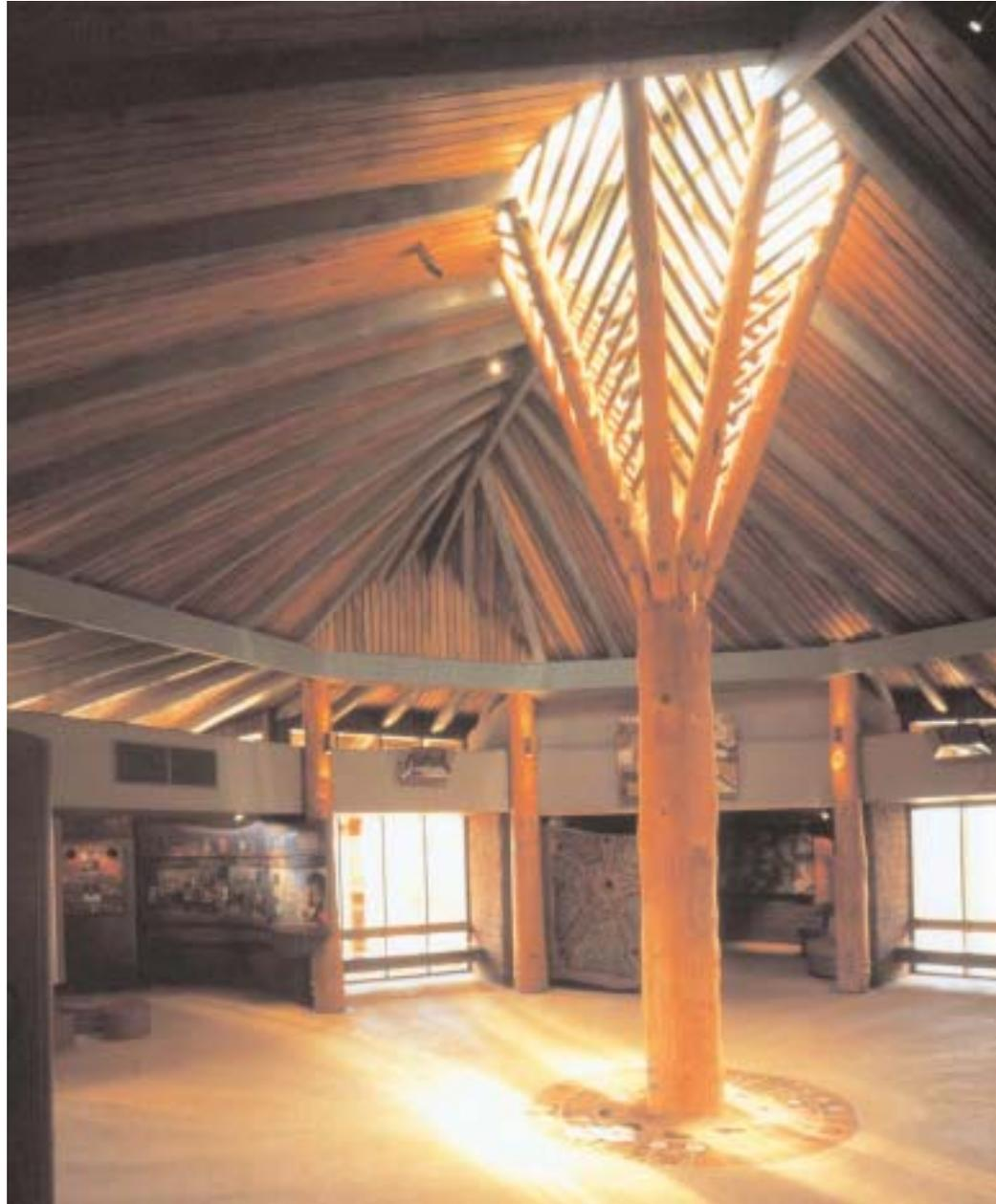
Interno dello spazio centrale con colonna ad albero strutturale e filtro di controllo dell'illuminazione naturale
