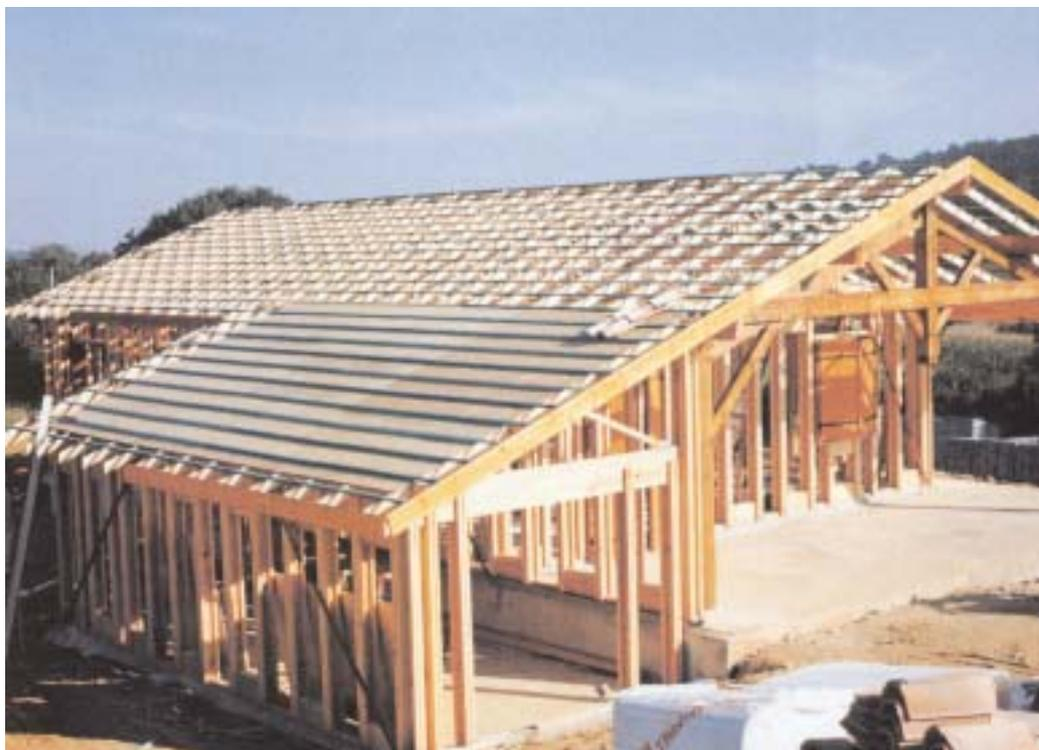
Fase di montaggio del manto di copertura in tegole
