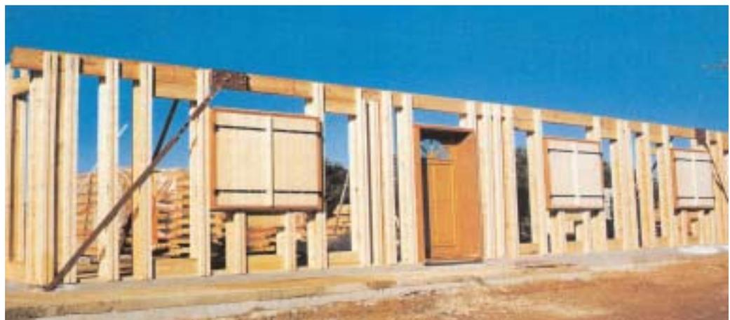
Immagine della struttura portante completata con vani porta e finestra, pronta per la tamponatura a ricorsi orizzontali in legno
