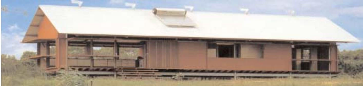
Prospetto Nord con in vista il termo-collettore e gli areatori eoliorientabili sul tetto
