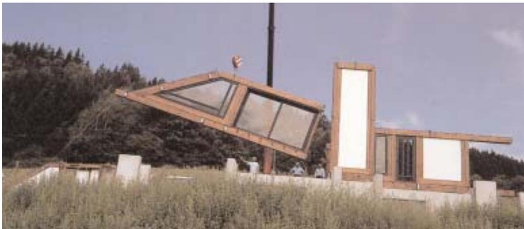
La posa in opera di una parete completamente finita, in cantiere
