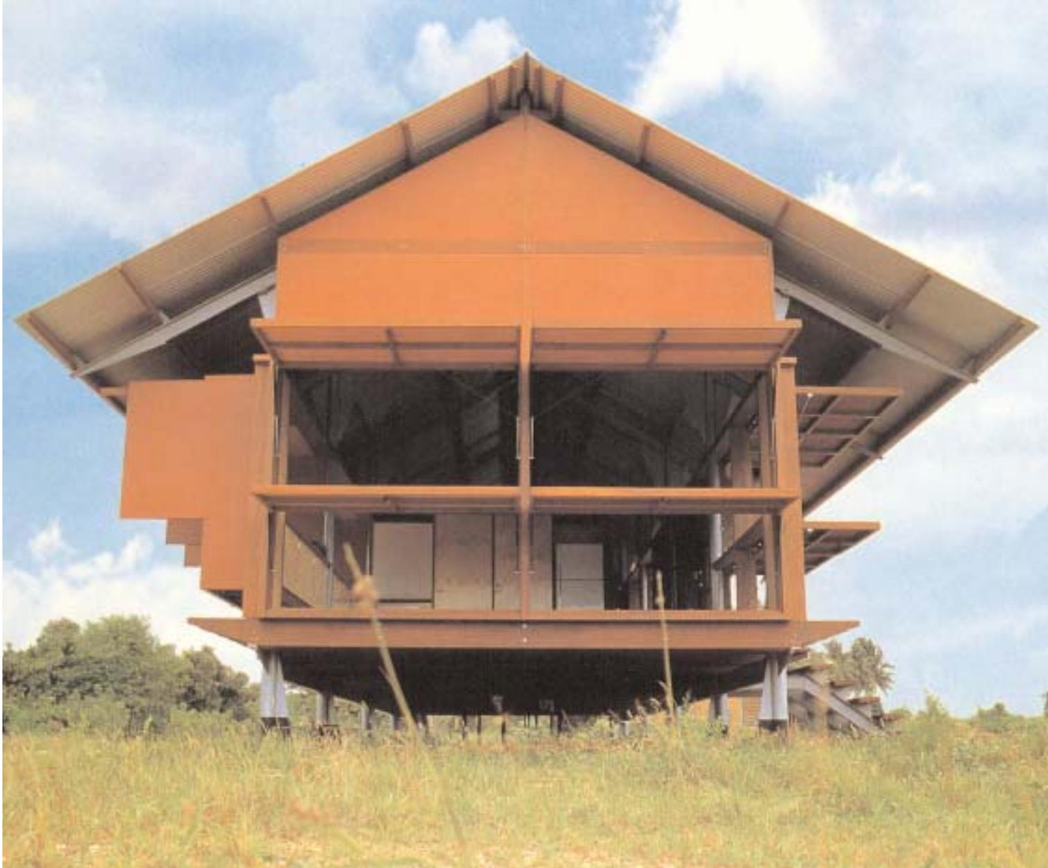
Vista del prospetto Est. Copertura in aggetto, pannelli frangisole e pannelli basculanti, volti a generare spazi d'ombra
